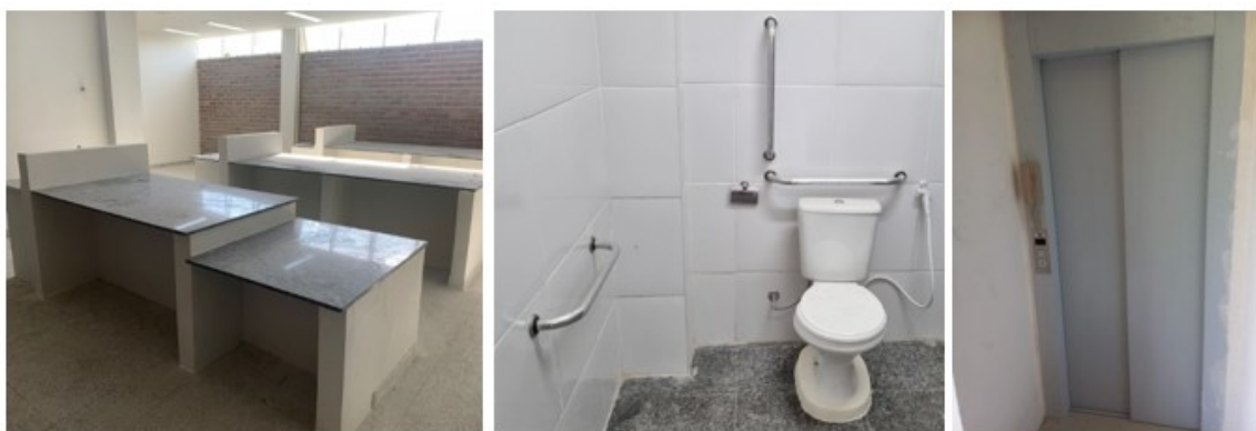
Figura 23 - Bancadas nos laboratórios com alturas distintas; banheiro acessível; e elevador para PNE.
