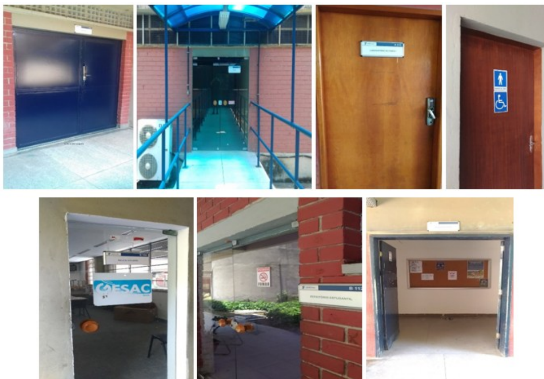
Figura 16 - Porta de acesso ao anfiteatro: folha dupla e fechadura de biometria; porta de acesso ao mezanino (baías de professores): folha dupla e fechadura normal e acesso por rampa sem inclinação e com barras de proteção; porta de laboratório com biometria na altura das mãos e identificação visual; porta de banheiro com maçaneta na altura das mãos e identificação visual; porta de acesso à sala de estudos com maçaneta na altura das mãos e identificação visual e com 0,90 m de largura; porta dupla com identificação visual - acesso ao refeitório 1; e porta dupla de acesso ao corredor das salas de aula do prédio 1 com 1,55 m de largura.
